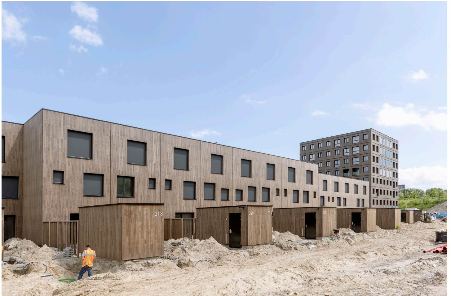
Switi in aanbouw (oplevering openbare ruimte staat gepland voor september 2025)
