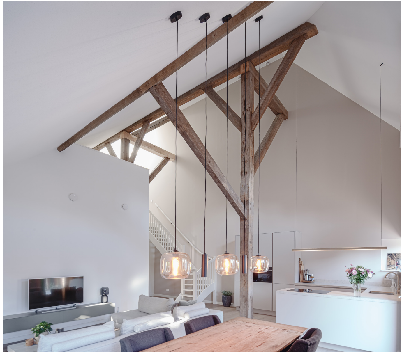
De houten draagstructuur blijft zichtbaar in het interieur van de woningen
