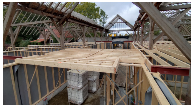
Houten verdiepingsvloer en wanden worden aangebracht
