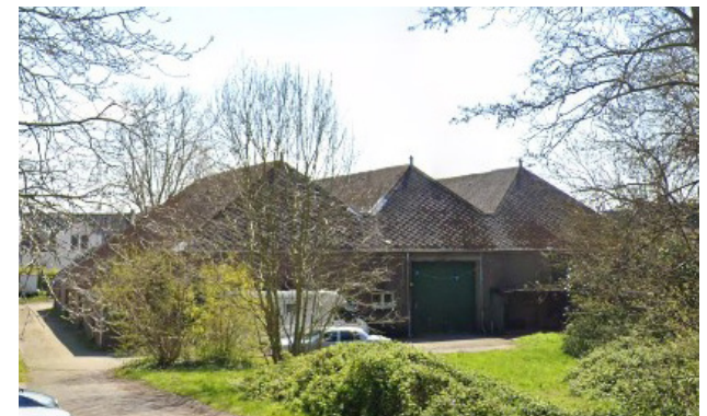
Bestaande situatie januari 2021 gezien vanaf de Zegwaartseweg
