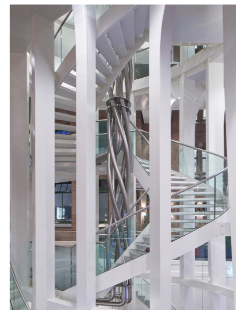
Hoofdramp met hemelwaterafvoerbuizen
