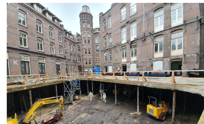
Uitgraving van het kelderniveau
