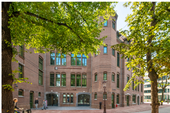
Nieuwe verbrede hoofdentree aan de Vendelstraat
