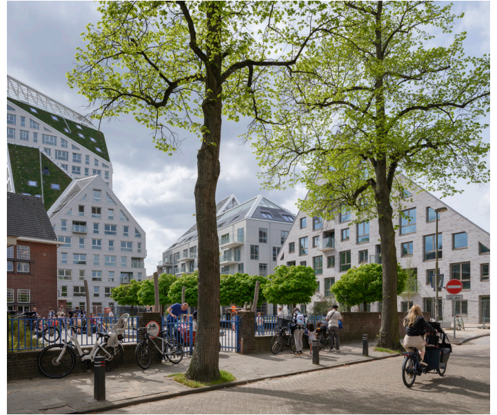
Achter twee transformaties verrijzen vijf nieuwe gebouwen
