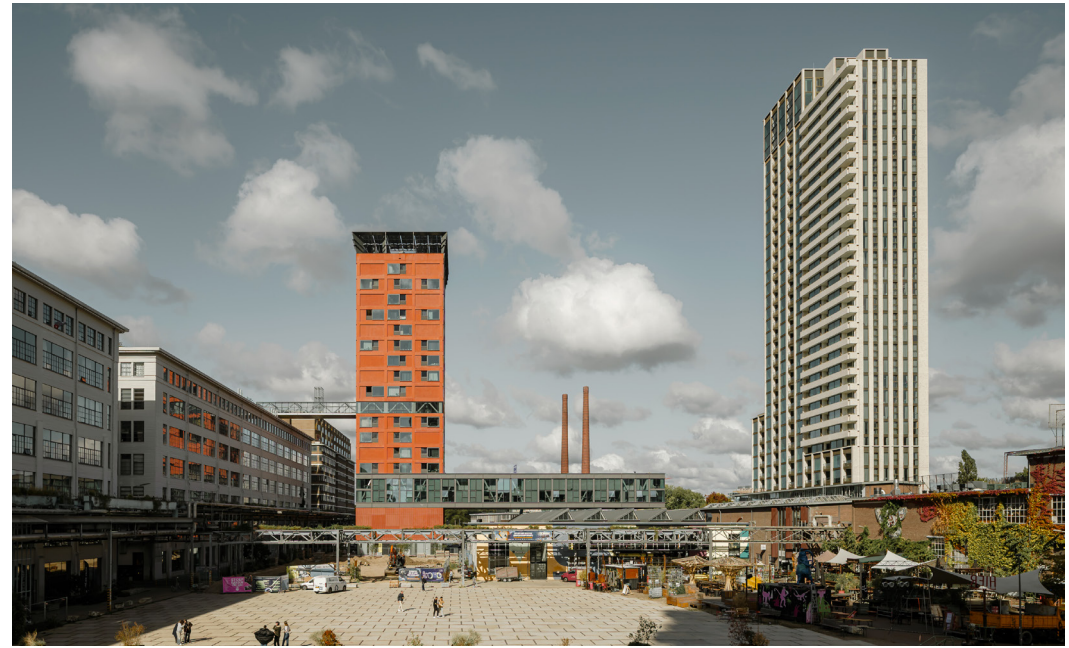
Huidige situatie Strijp-S met De Hoge Rug, Haasje Over en Lighthouse aan een levendig plein.
