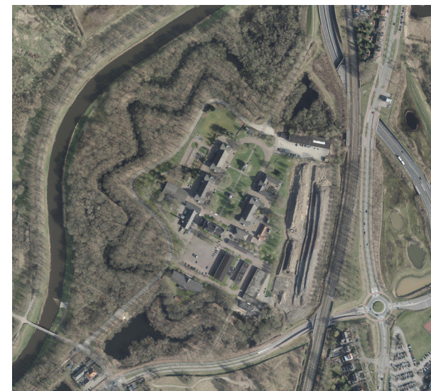
luchtfoto Fort Isabella voor de herinrichting tot nieuwe buitenstad
