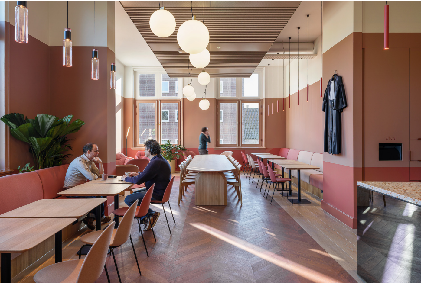
Door vijf lokalen samen te voegen is er een ruime mensa gecreëerd, door de penanten te laten staan zijn de oorspronkelijke lokalen nog te herkennen
