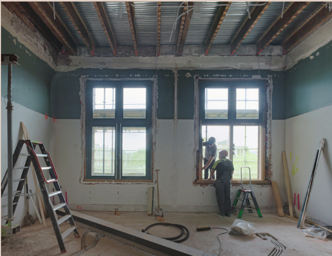
Klaslokaal tijdens de uitvoering: vakmanschap en oog voor detail bij de aannemer
