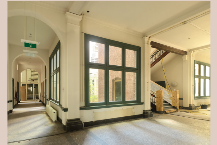
Begane grond gestript, ramen zijn vervangen voor openslaande deuren naar binnenplaats
