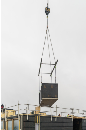
modules worden ingehesen
