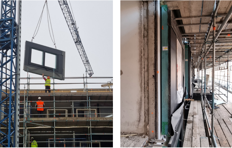
het bestaande casco wordt ingepakt met houtskeletbouw geveldelen
