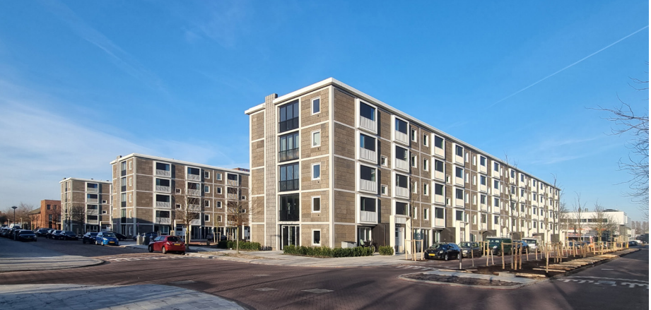
van de 6 oorspronkelijke flats zijn er 3 behouden
