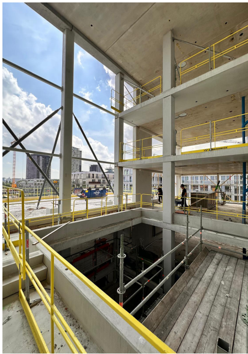
De gevel is in een vroeg stadium samen met de producent ontworpen, waardoor veel aandacht kon worden besteed aan de detaillering. Binnen een prefab systeem werd een bijzondere vorm gerealiseerd: ondiepe balkons met gekromde plafond, gedragen door elegante, kruisvormige kolommen.
