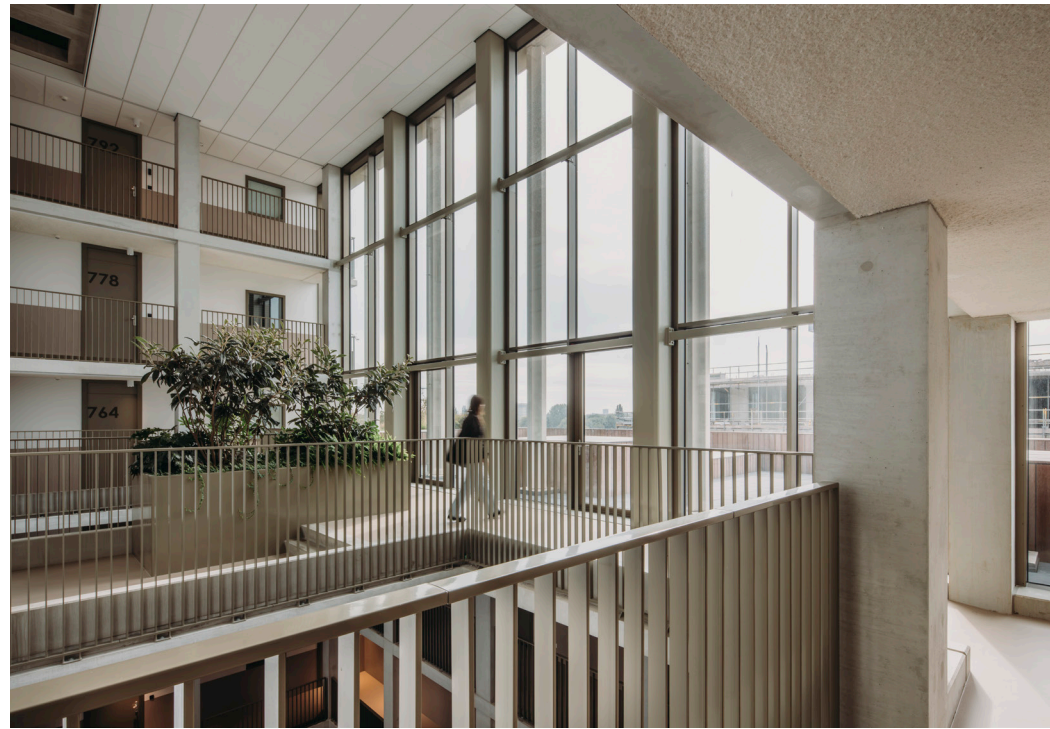
Casco in aanbouw en eindresultaat van De Louise. Volledig prefab casco en gevel maakten een efficiënt bouwproces met verkorte bouwtijd mogelijk.
