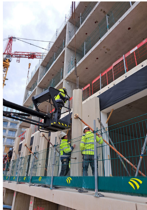
De gevel is in een vroeg stadium samen met de producent ontworpen, waardoor veel aandacht kon worden besteed aan de detaillering. Binnen een prefab systeem werd een bijzondere vorm gerealiseerd: ondiepe balkons met gekromde plafond, gedragen door elegante, kruisvormige kolommen.
