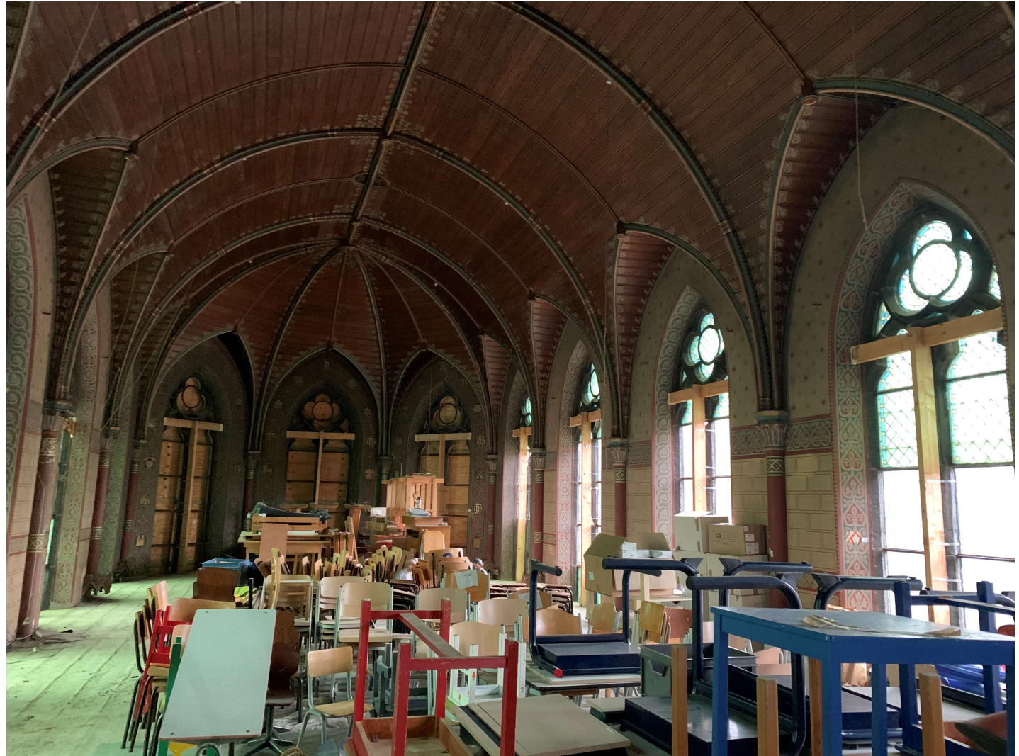
Stockage boven betonnen tussenvloer (2020)
