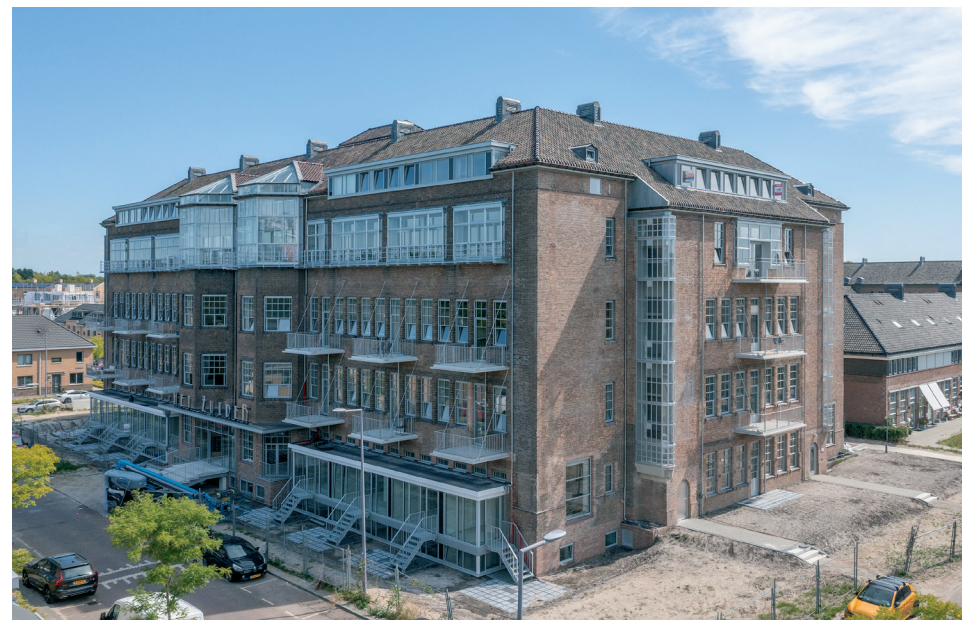
Noord- en westgevel met balkons en serre's rondom de hoofdentree
