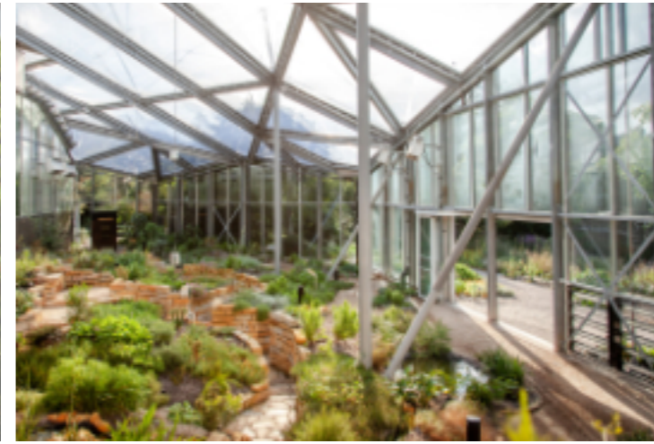
Vernieuwde Kaapse kas met open te zetten schuifdeuren, temperatuurgevoelige automatische dakluiken en gevellamellen
