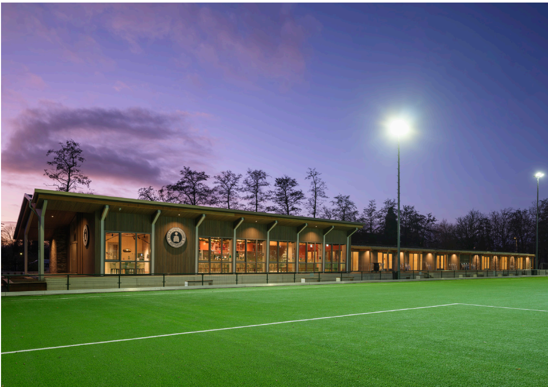
De betonnen spanten staan telkens op 3,3 meter van elkaar. Dit ritme is doorgezet in de uitbreiding met kleedkamers.
