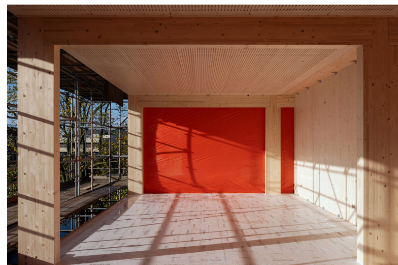
De belangrijkste stap: een open draagstructuur van massief hout creëert een CO 2 -arme, open en aanpasbare gebouwstructuur.
