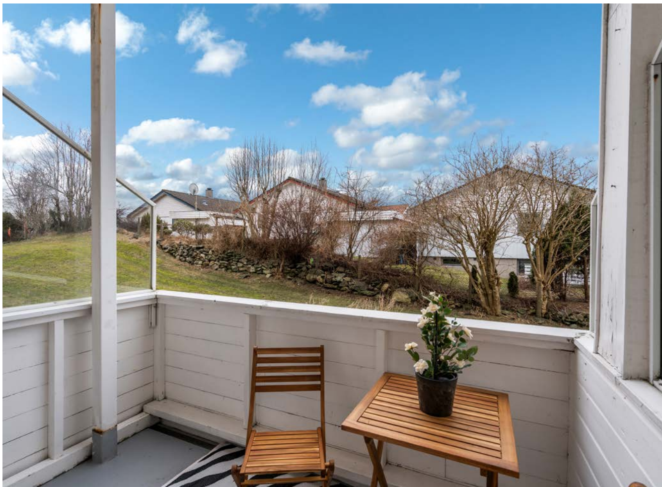
Det skal i 2026 bygges innglassede balkonger fra Balco, fornying av diverse utvendig fasade på bygget med mer.
