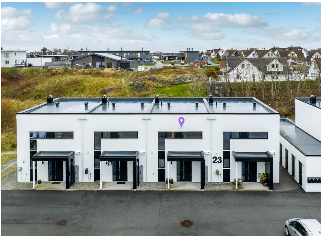
Boligen ligger i rekke, sammen med 3 andre boliger. Bod i felles anlegg.
