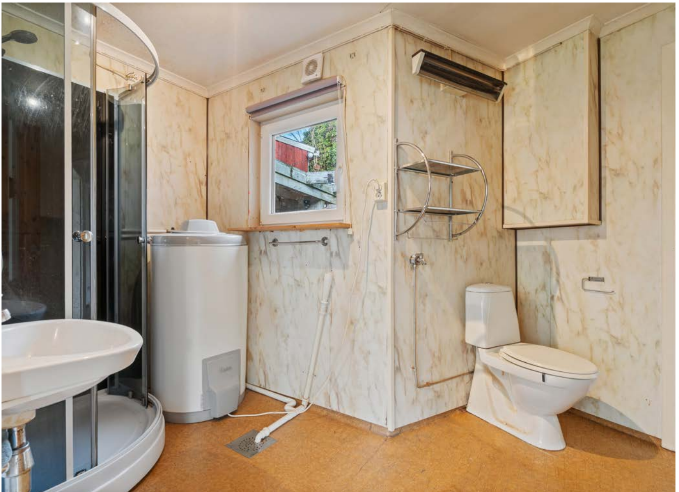
Bad/wc med dusjkabinett og opplegg for vaskemaskin
