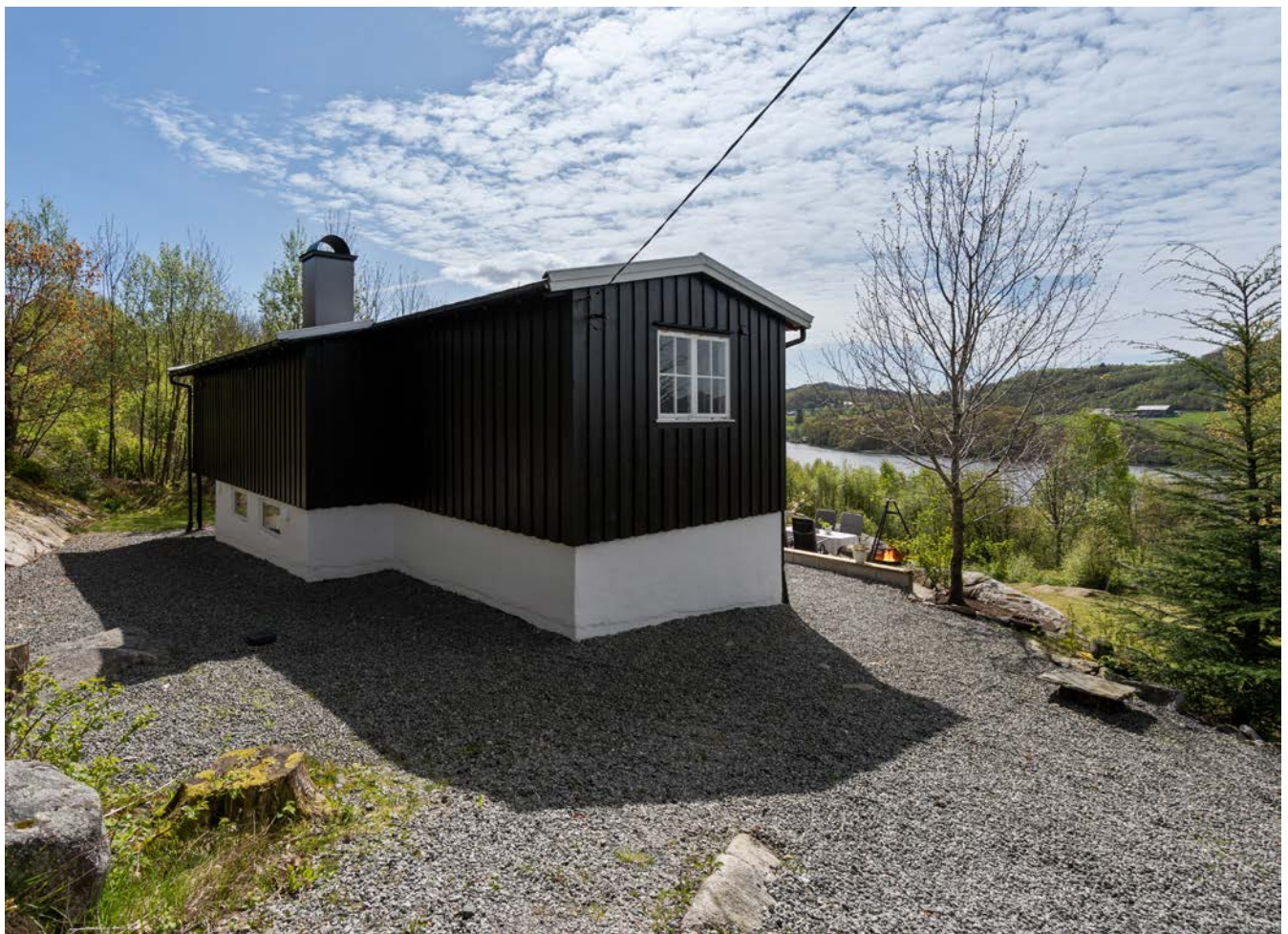
Ny drenering og etterisolering av grunnmur (2021).
