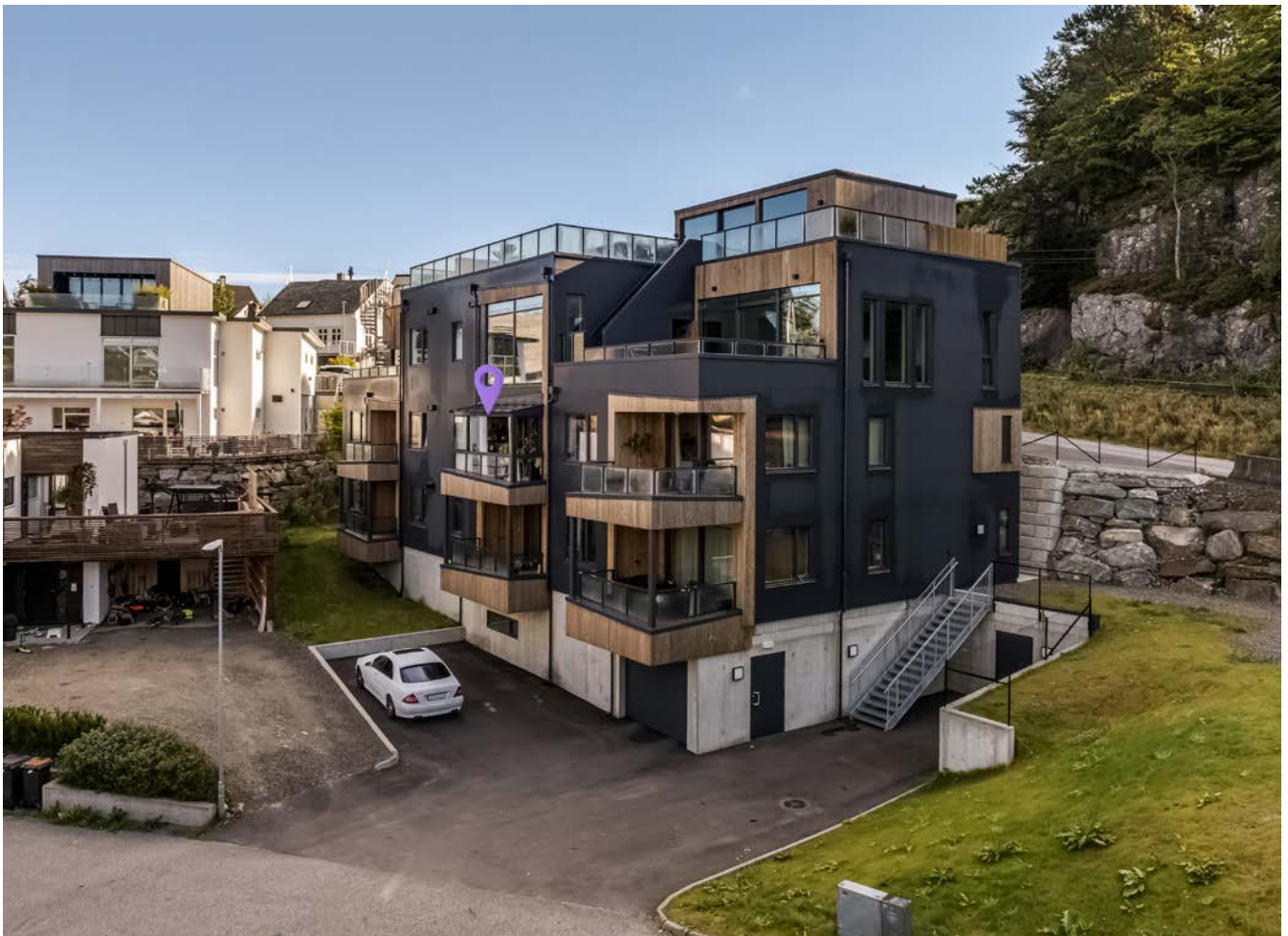
Bygget har heis.
