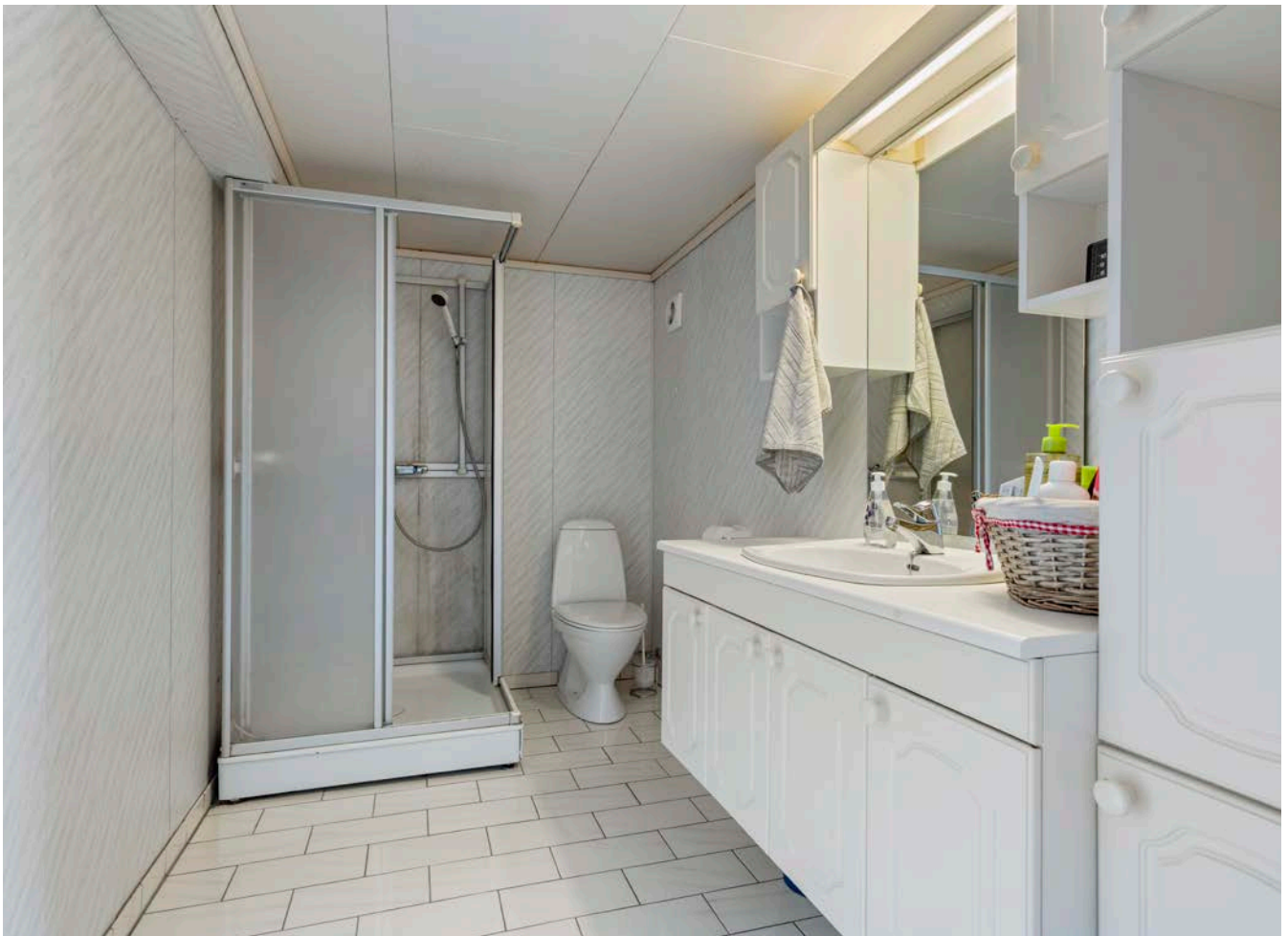
Bad i underetasjen.
