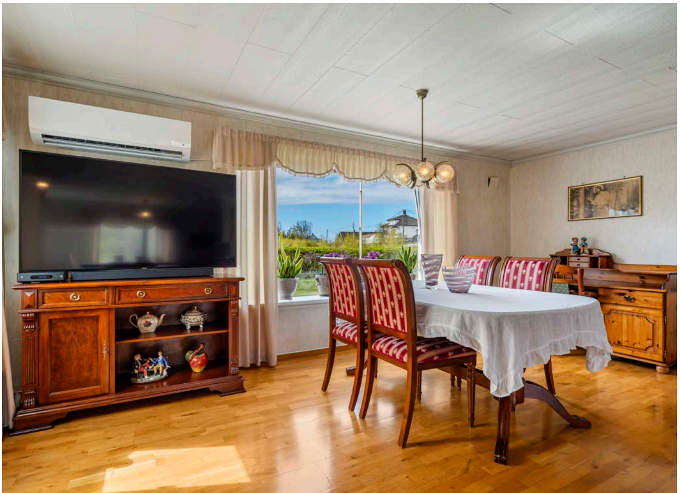
Nyere stor varmepumpe.
