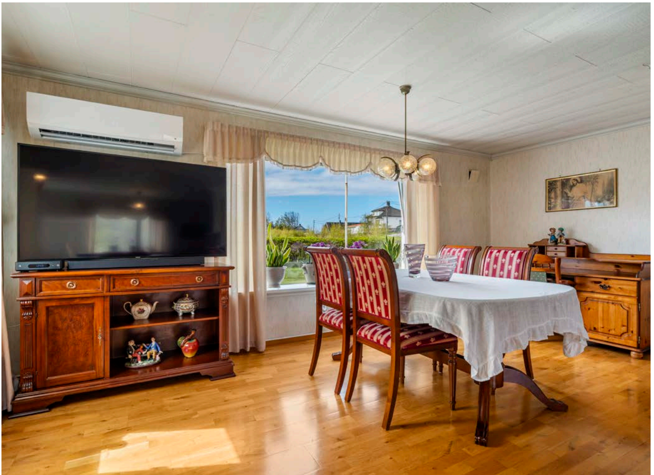
Nyere stor varmepumpe.
