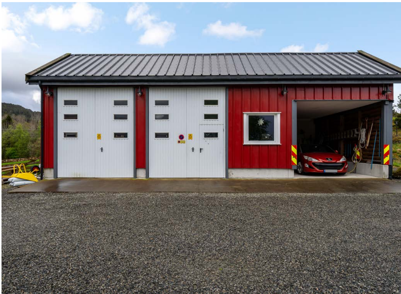
Garasje/verksted/lager i 2016 er i solid utførelse og fremstår tilnærmet som nytt.
