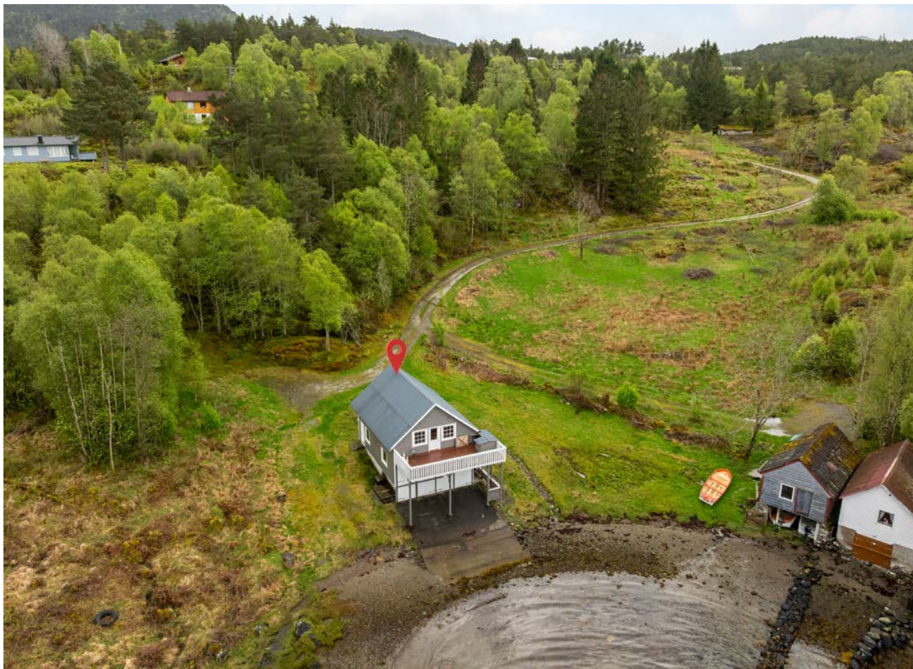
Uinnredet naust med loft. Naustrom nede og bøteloft med balkong oppe. Enkel standard. Oppført år 1999-2000.
