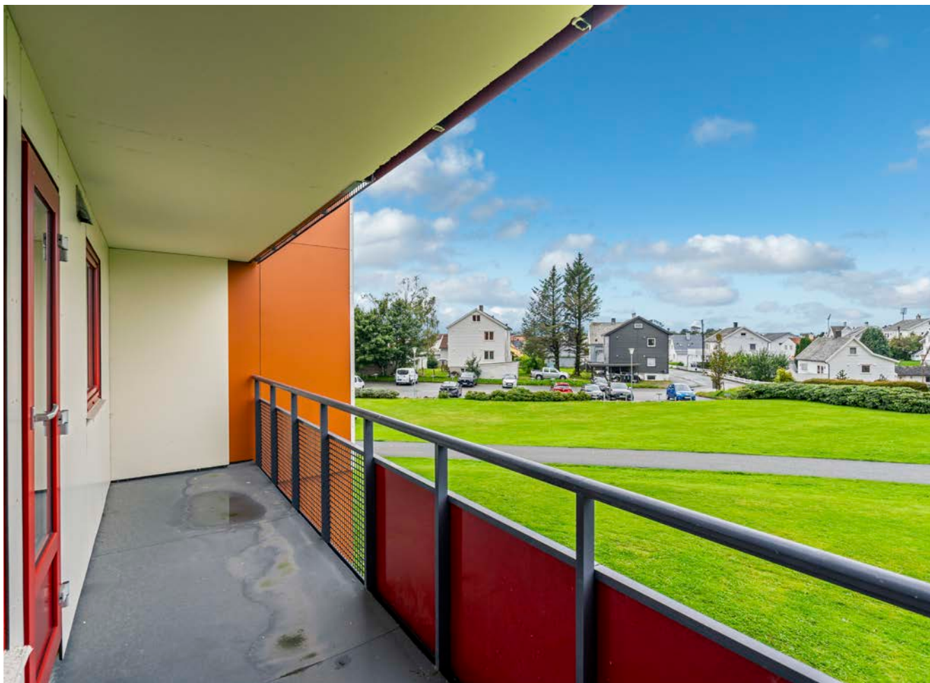
Balkong med støpt dekke belagt med sarnafil. Balkong renoverert i 2023-2024.
