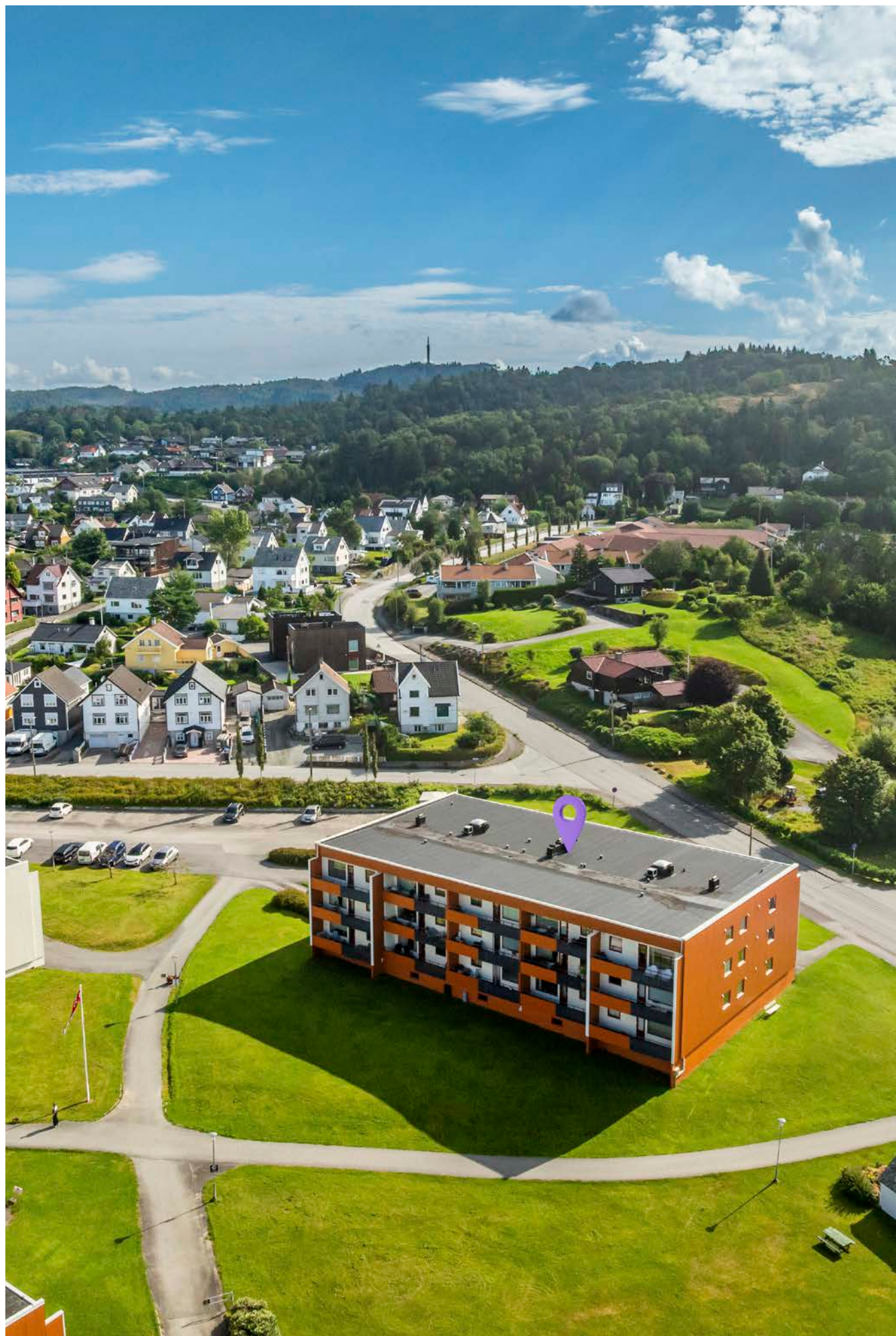
Sentral plassering. Bygget er renoverert utvendig i nyere tid - 2022-24.
