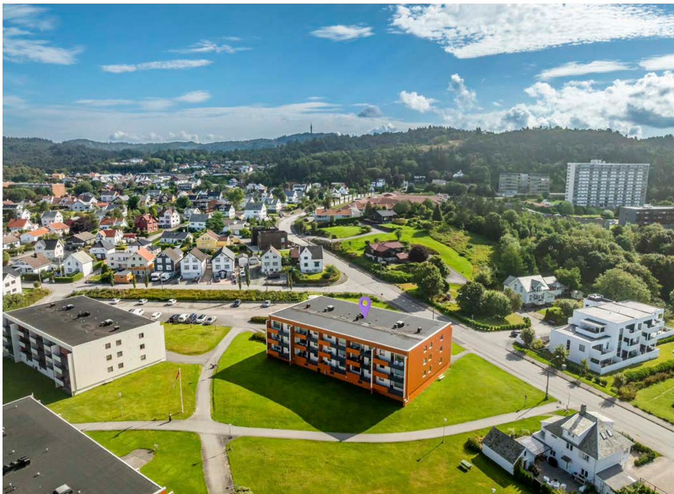
Sentral plassering. Bygget er renoverert utvendig i nyere tid - 2022-24.
