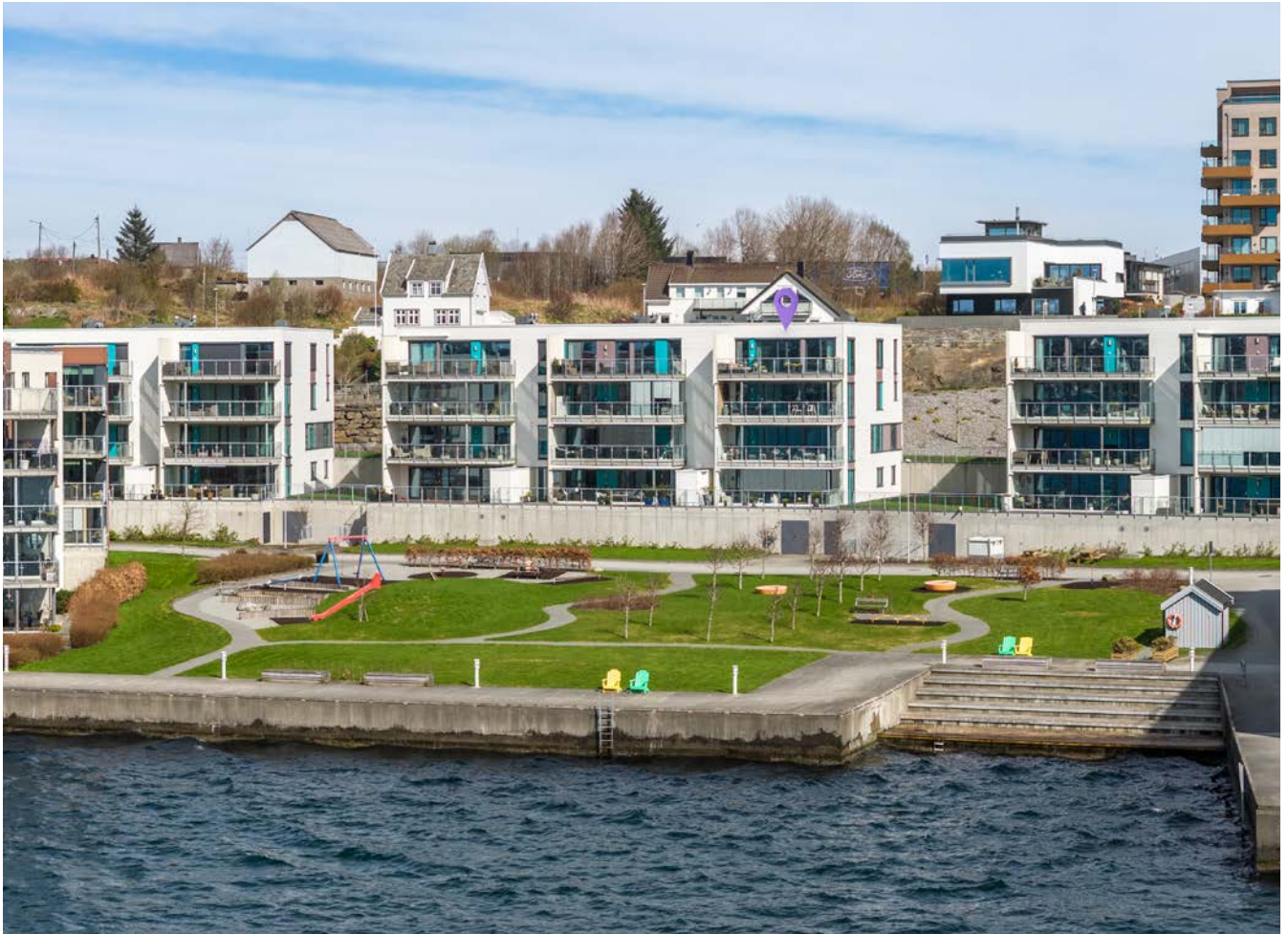
Toppetasjen i hjørne, parkanlegg og badeplass
