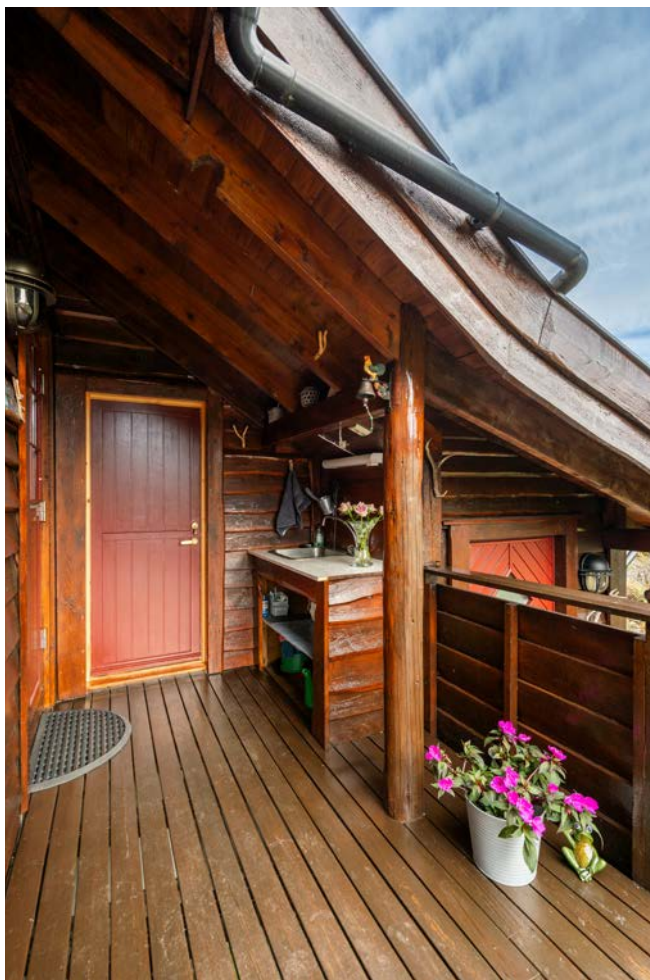
Inngangspartiet er overbygget
