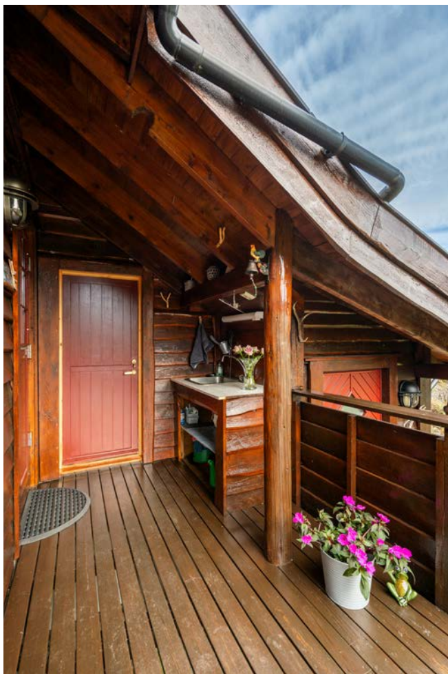
Inngangspartiet er overbygget
