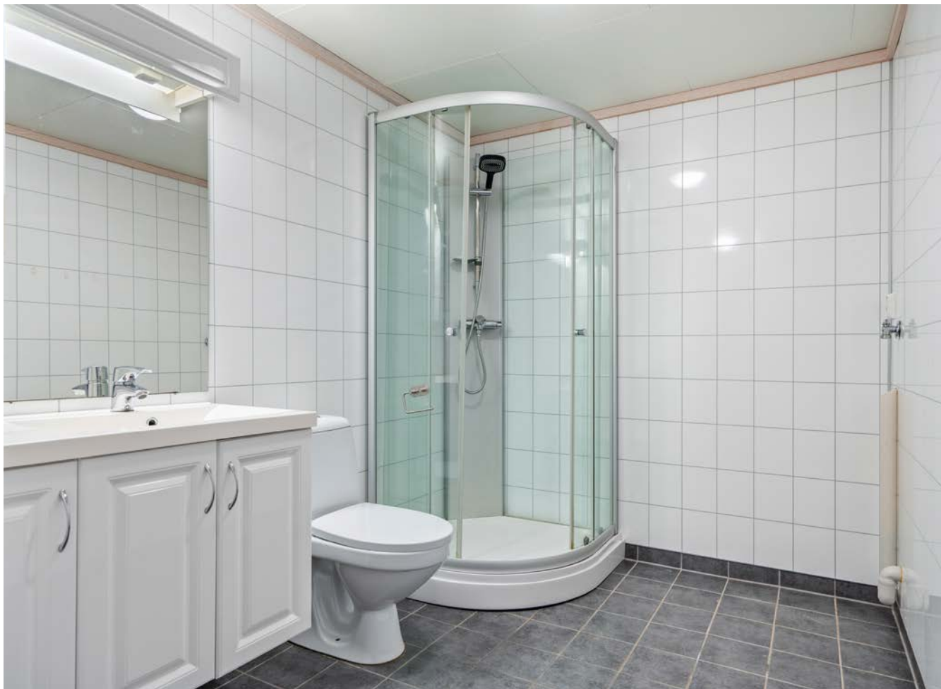
Bad med fliser på gulv, varmekabler, dusjkabinett og vaskesøyle
