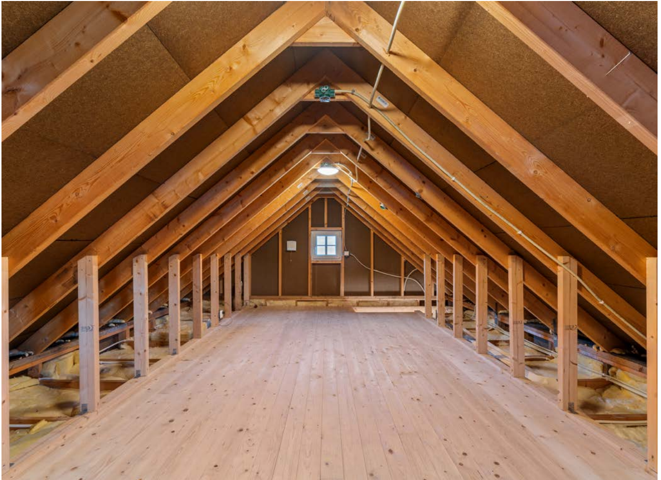
Taket er selvbærende så man kan sette opp eller fjerne innvendige vegger som en ønsker.
