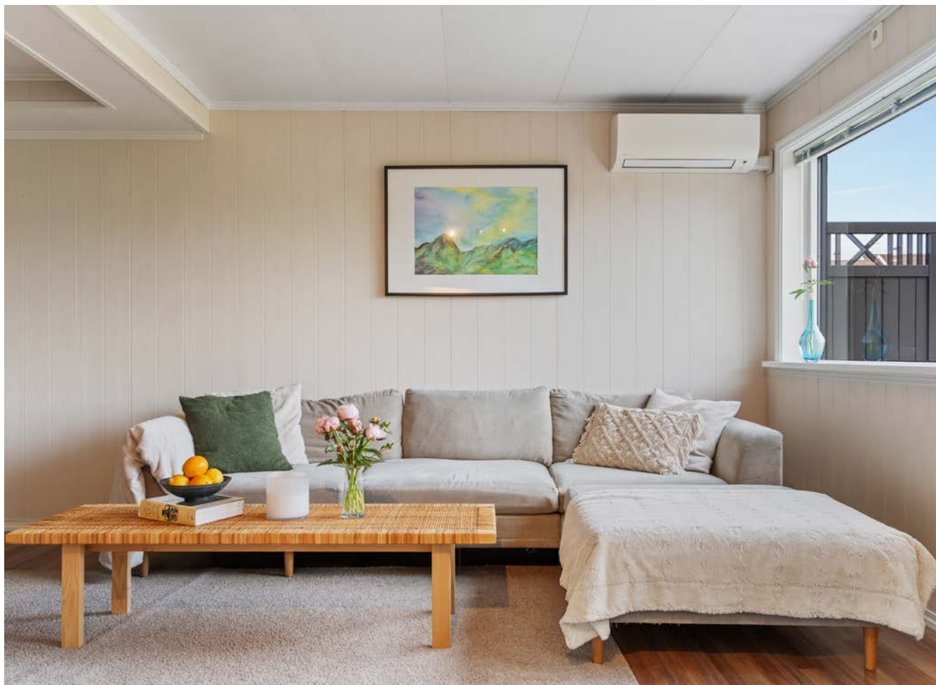
Det er monteret varmepumpe i stue
