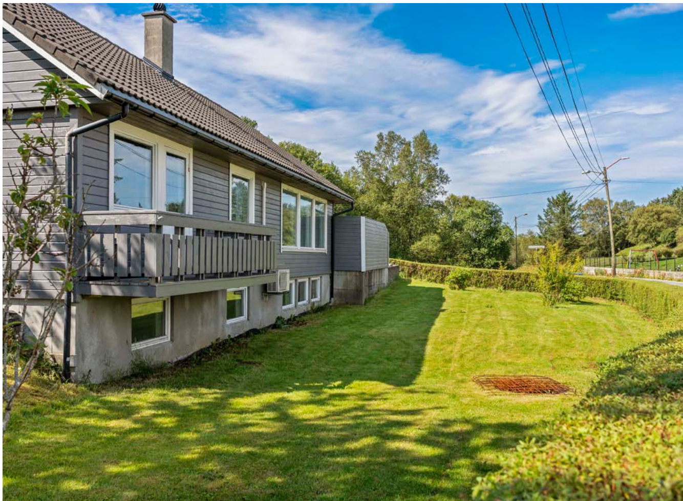
Pent opparbeidet tomt med asfaltert gårdsrom og plen med diverse beplantning.
