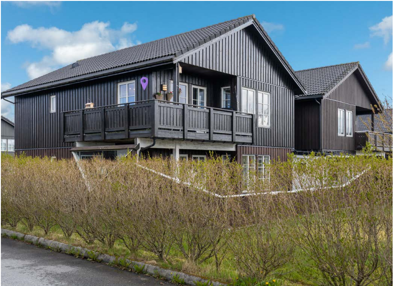
Leiligheten er nylig beiset utvendig (2025).
