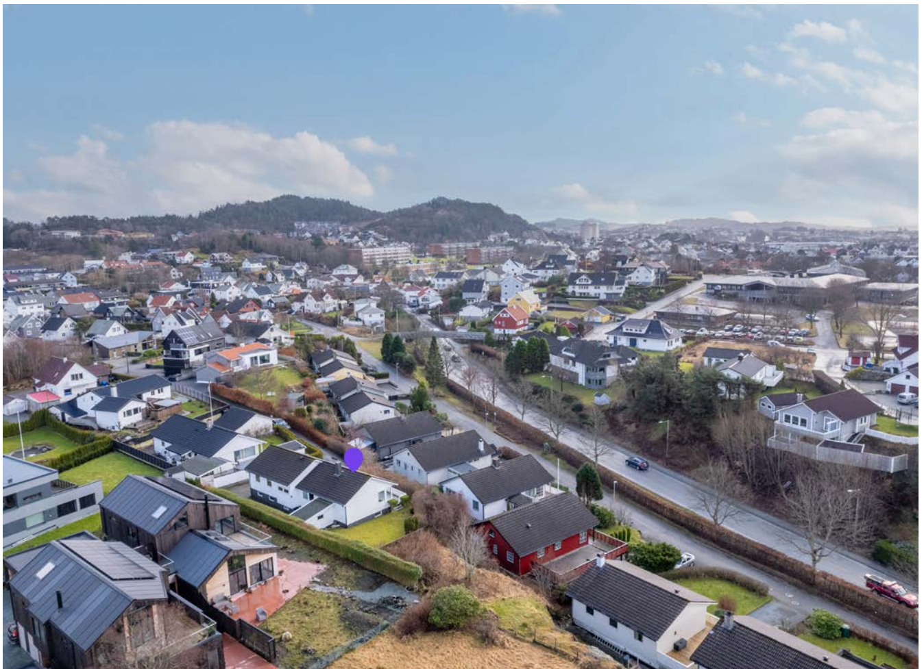
Fasade, bilde tatt mot sørøst
