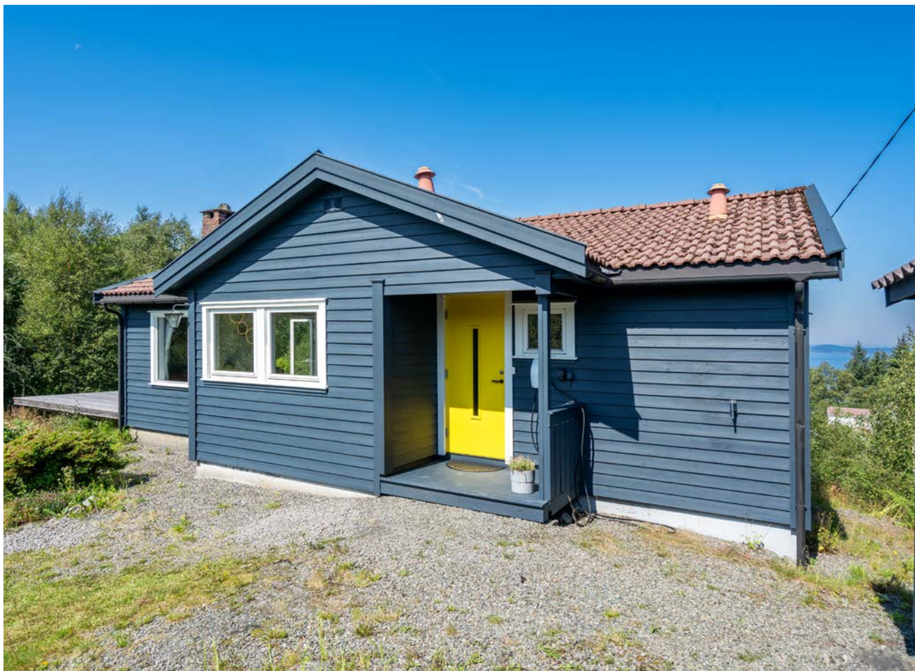
Ved inngangspartiet er det montert el-billader
