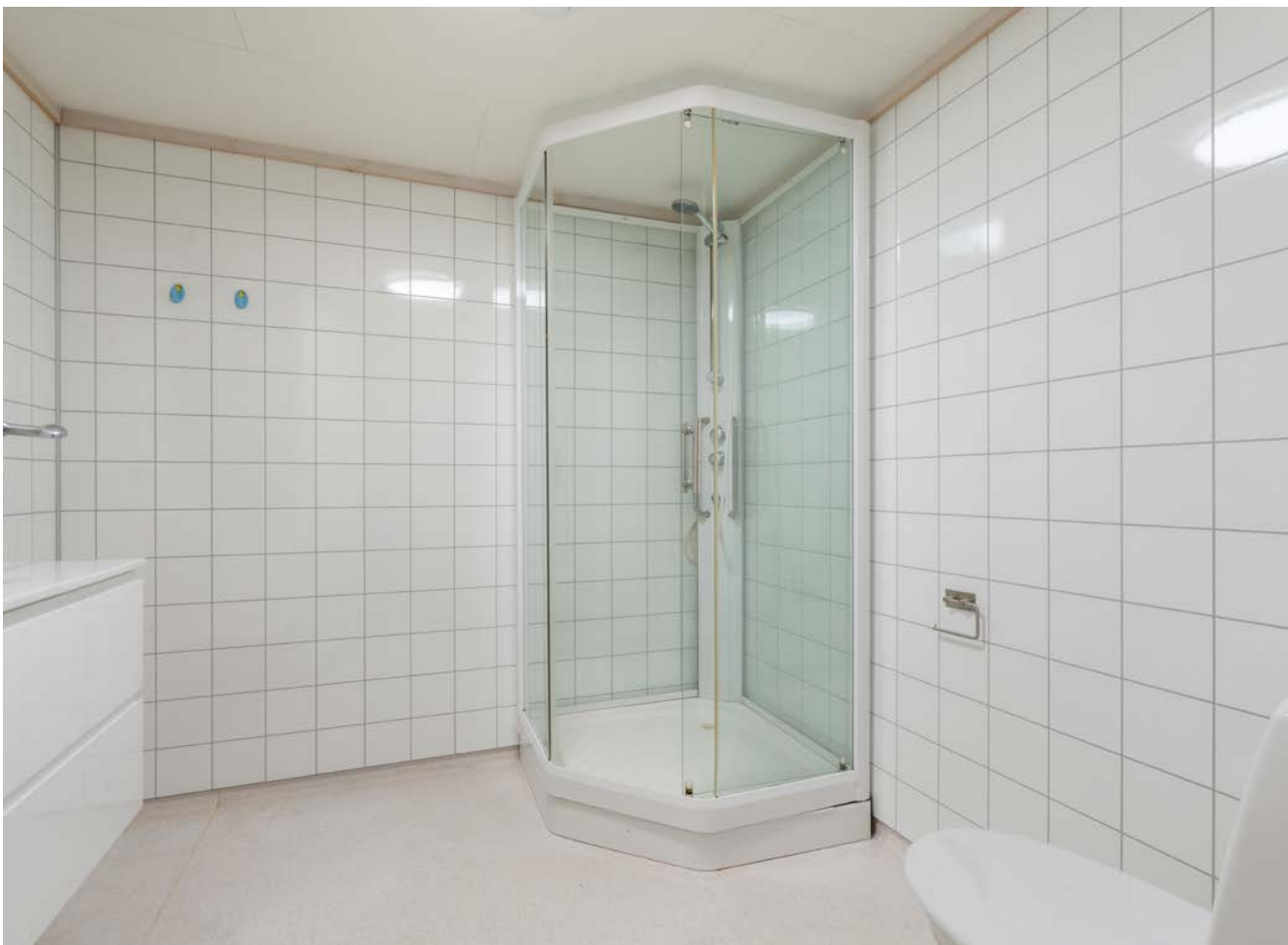
Belegg og varmekabler på gulv, våtromsplater på veggene og dusjkabinett
