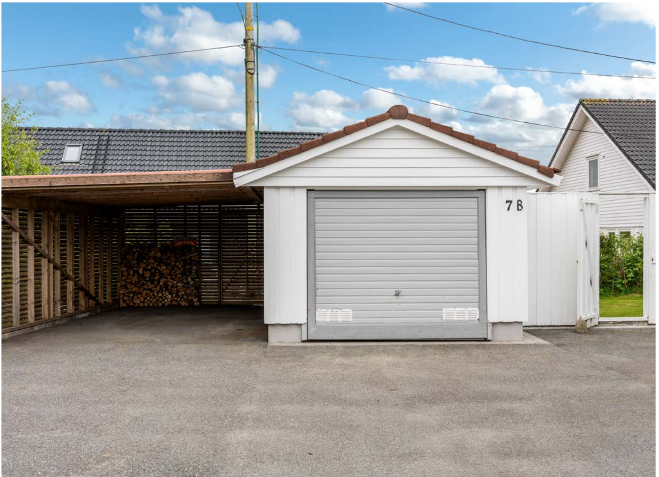
Garasje og carport 7 B står det, men korrekt er A
