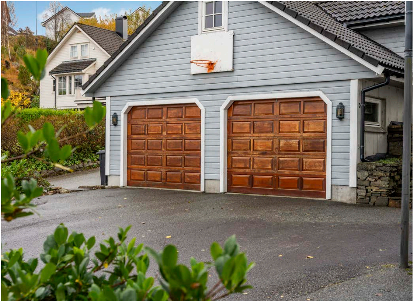
Garasjen har 2 elektriske leddporter. I garasjen er det 2 el-billadere
