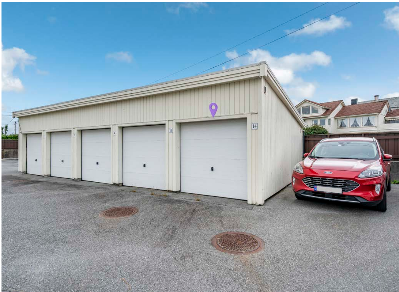
Garasjeplass i fellesanlegg
