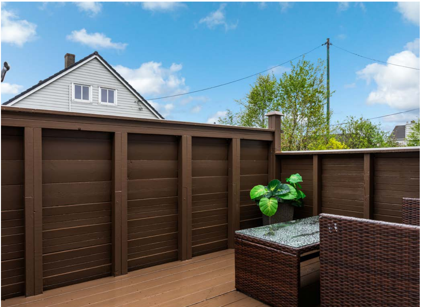
Terrassen er oppført i normalt solide trematerialer, typisk bjelkelag, terrassebord og rekkverk i tre.
