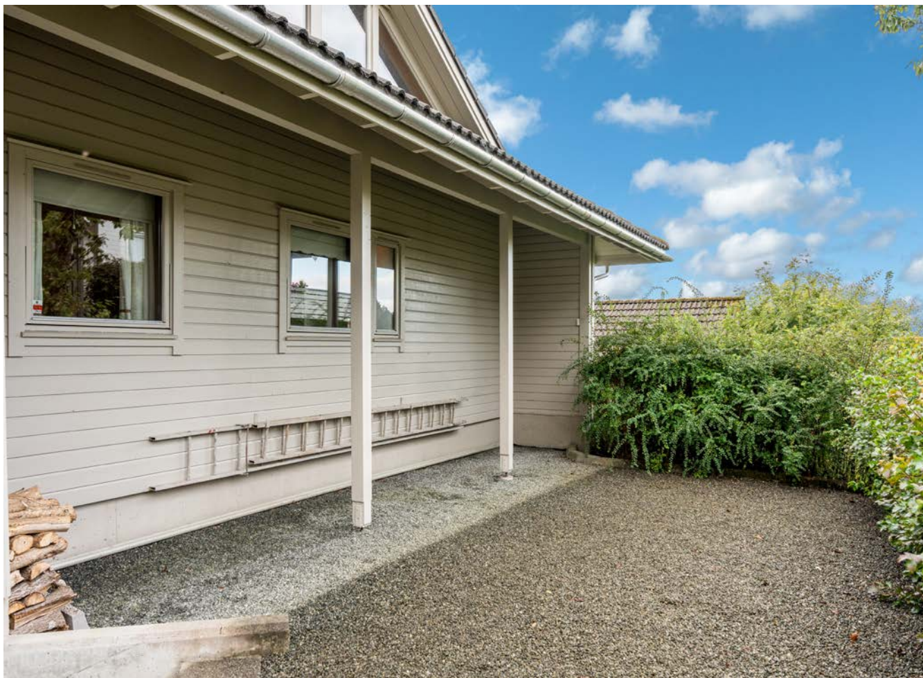
Uteplass på nordsiden av boligen
