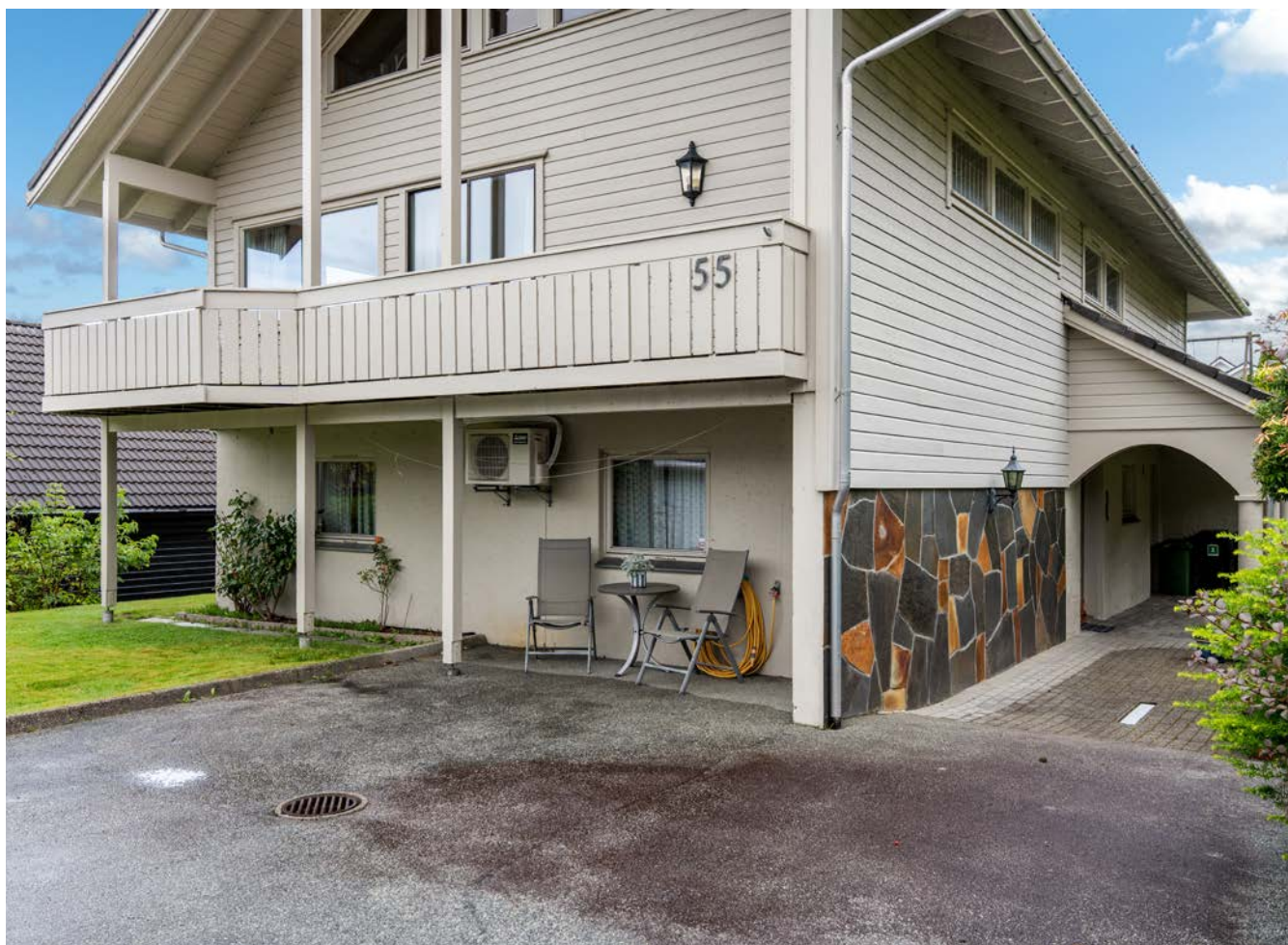
Velstelt på utsiden av huset
