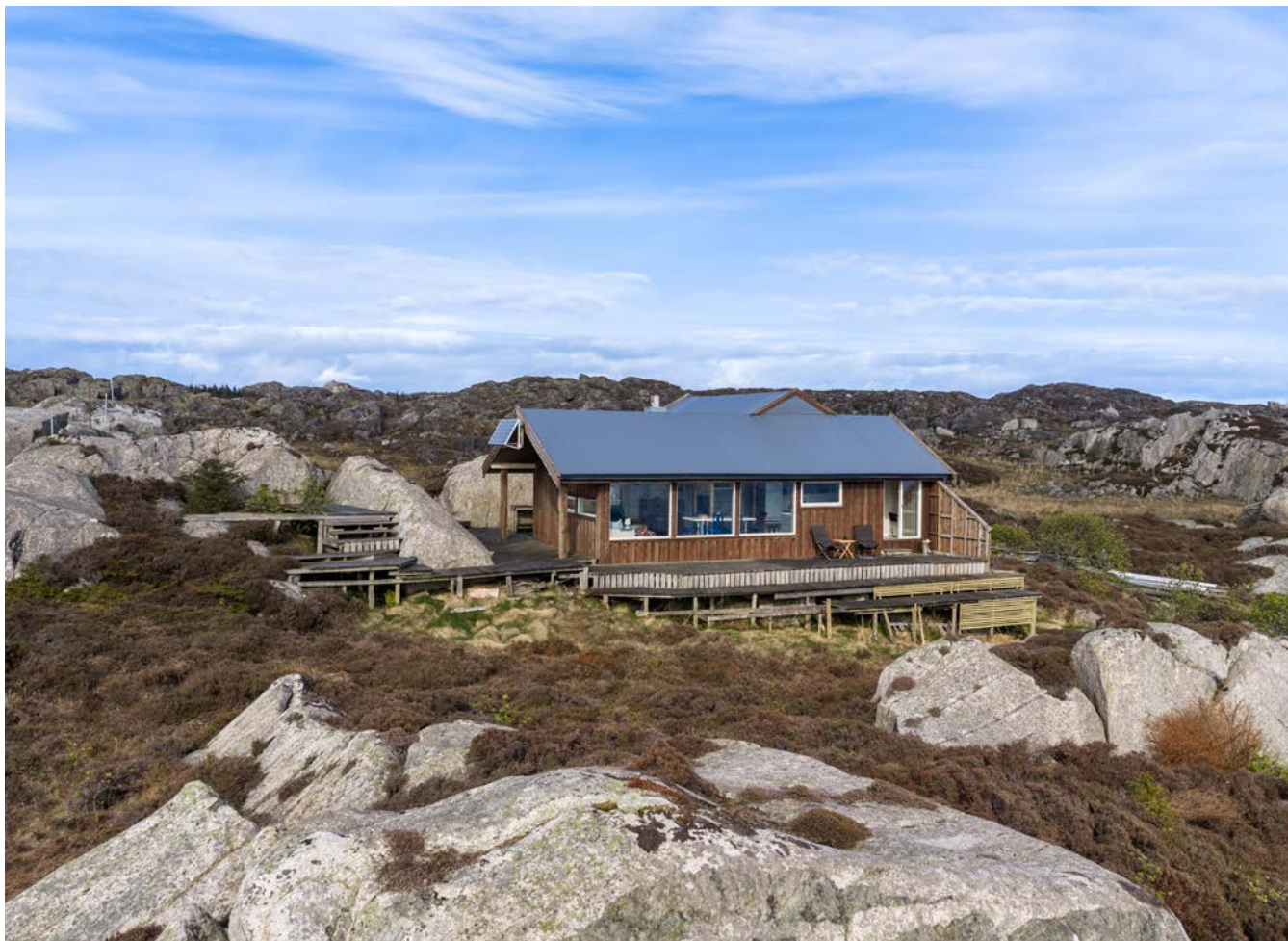
Fasade, solcellepanel mot sør
