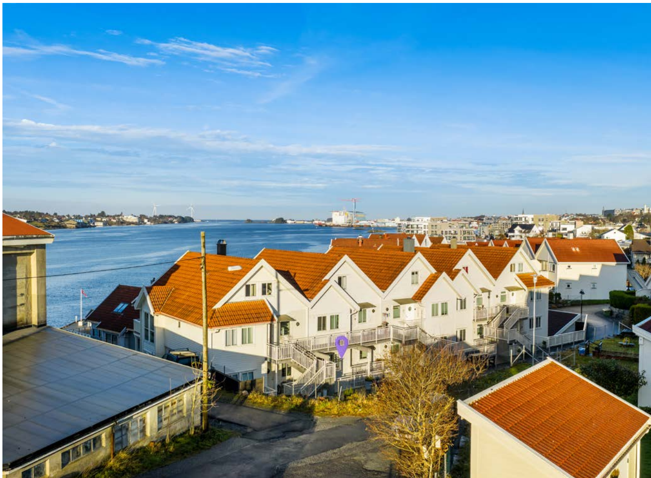
Inngangsparti med trappefri adkomst.
