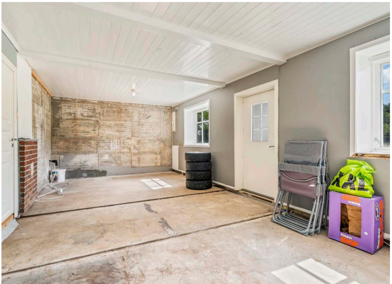
Kjelleretasjen er strippet og klar for nye eier til å utforske mulighetene og innrede slik man måtte ønske.
