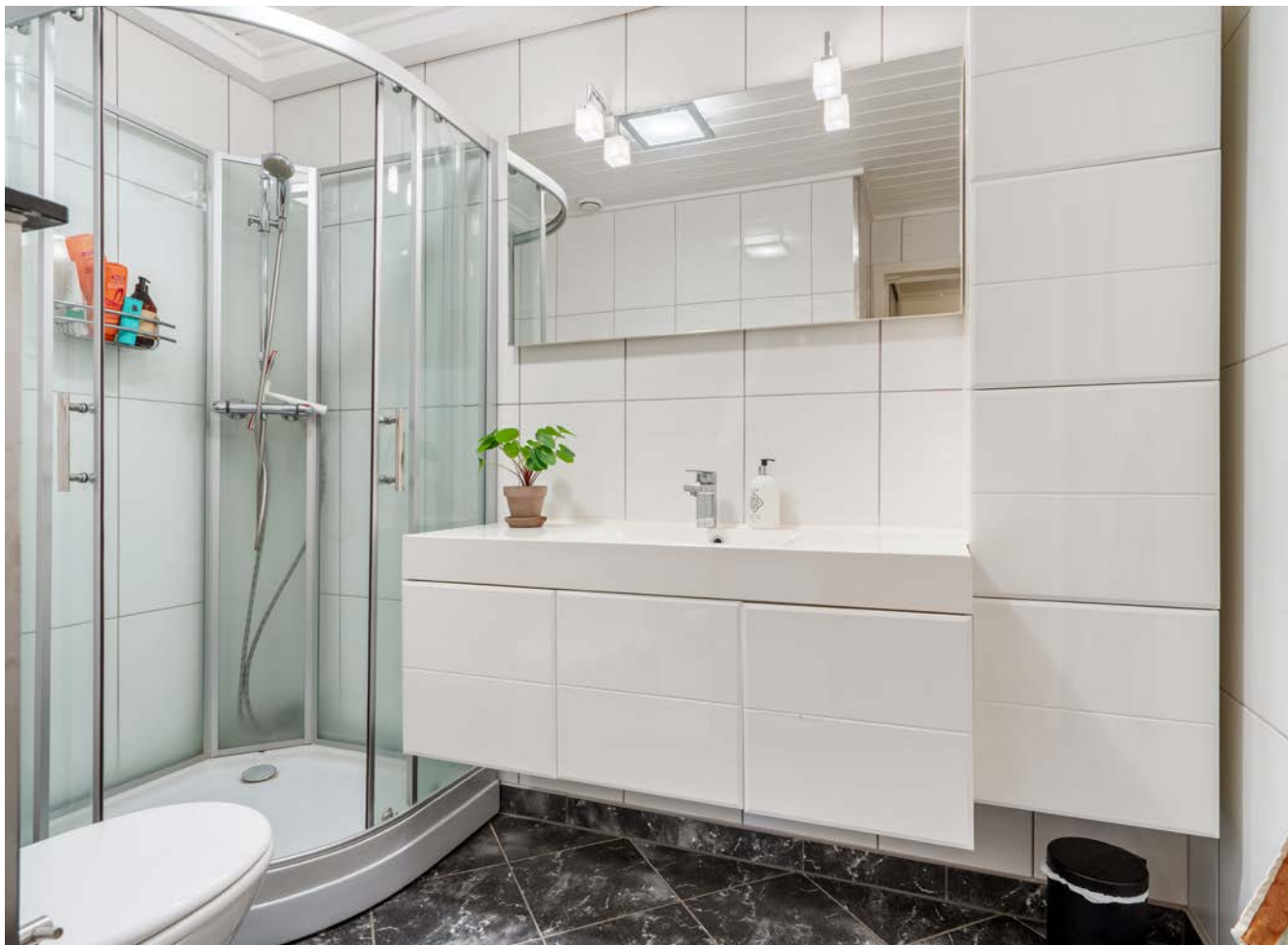
Flislagt bad i underetasjen
