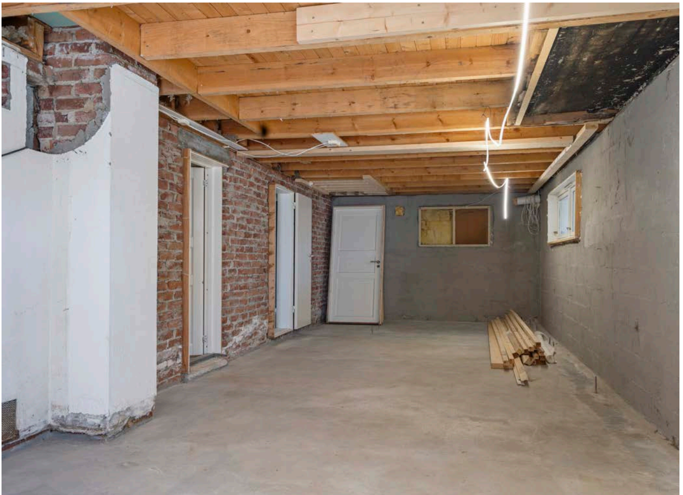
- Uinnredet rom i kjeller med muligheter for videre utvikling. Kjelleren er adskilt fra resten av boligen og har egen inngang -
