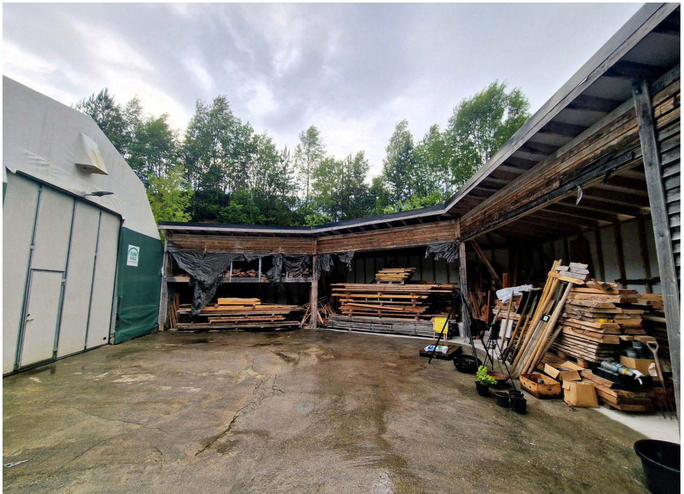
Verkstedhallen ligger like inntil materiallageret.
