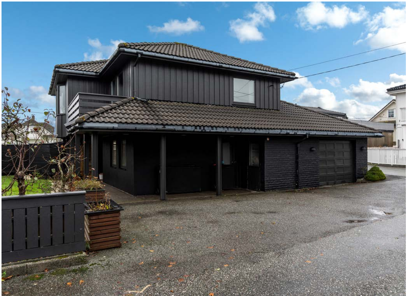
Bi-inngang til vaskerommet og inngang til garasjen.
