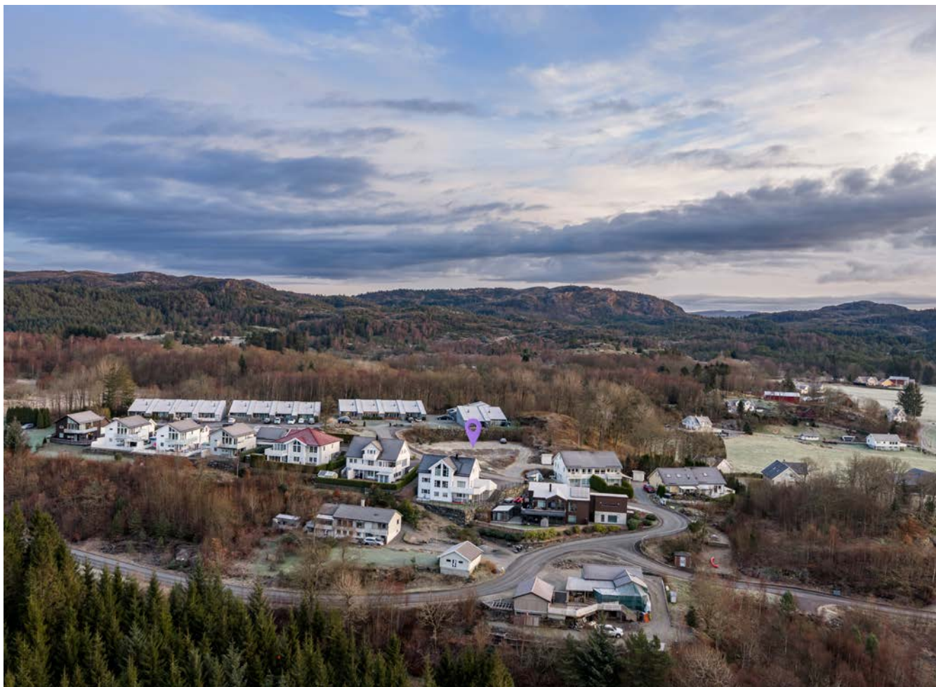
Feltets tomter er knyttet til et gass-distribusjonsnett som eies av Norsk Gassnett AS. Det er felles tank for propangass.
