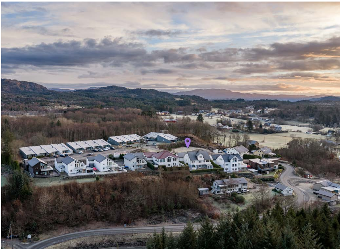
Stikk for vann og kloakk er lagt inn på tomten.
