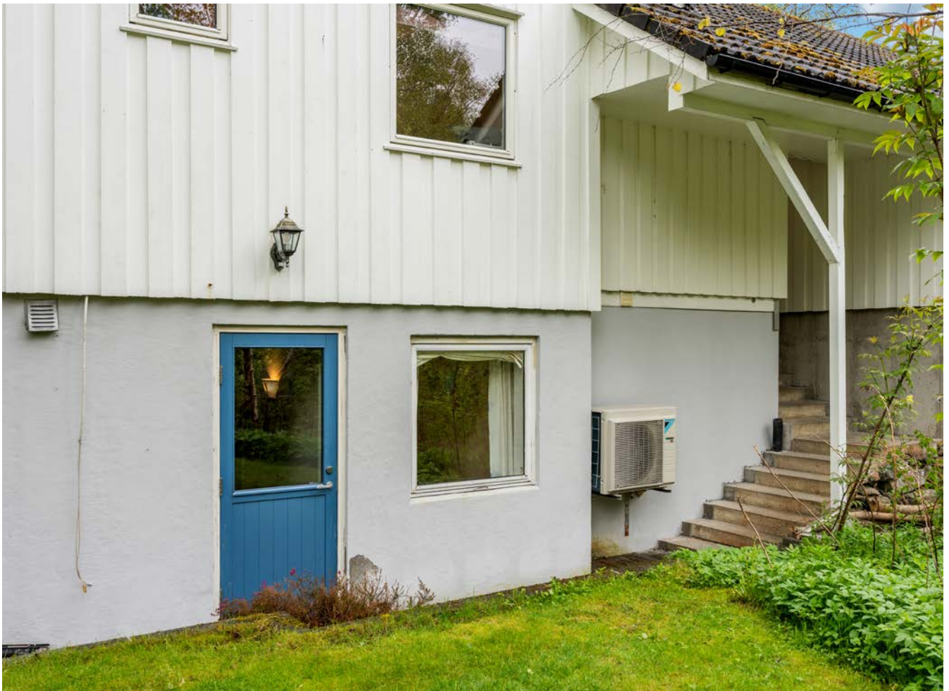
Inngang til kjelleretasjen.
