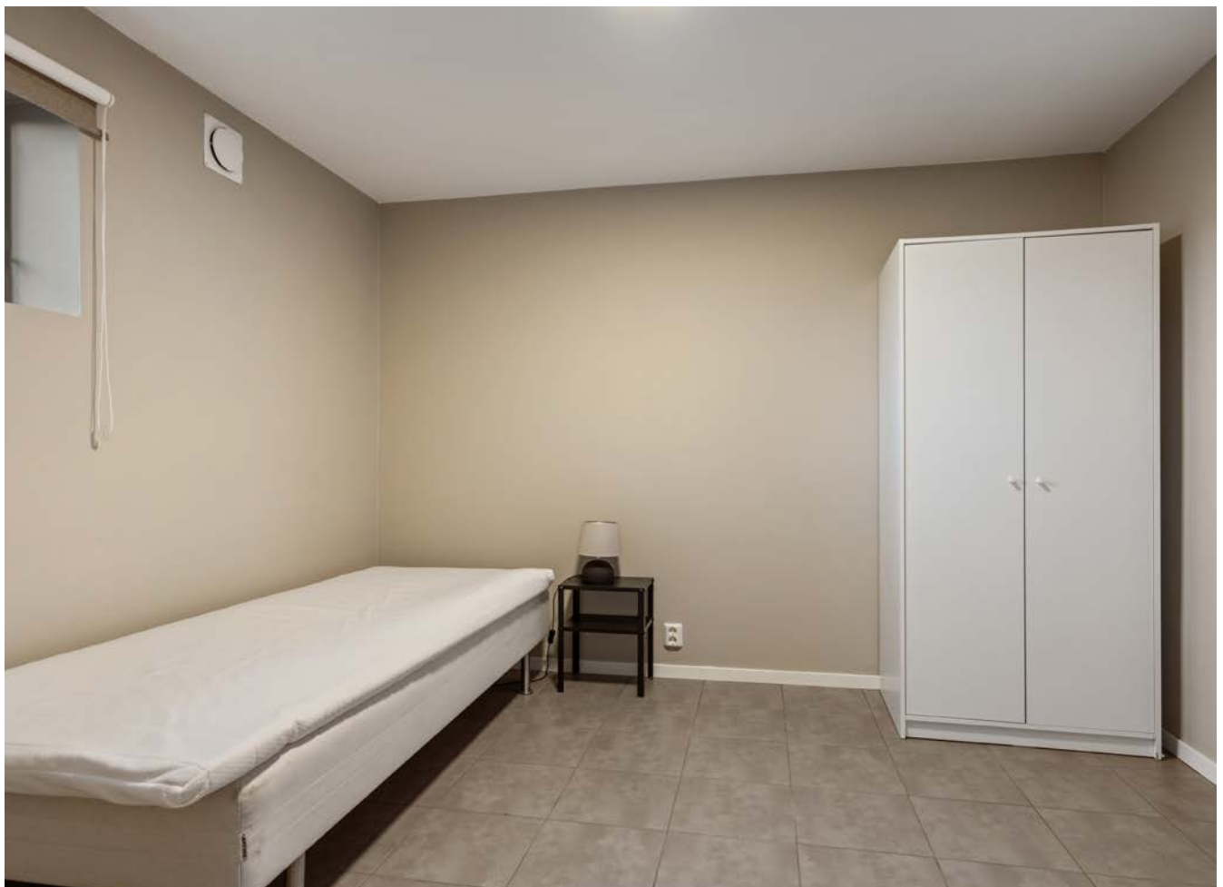
Soverom/bod med flislagt gulv og varmekabler. Vinduet her er sprukket. Rullegardin i vindu. Dobbelt garderobeskap.
