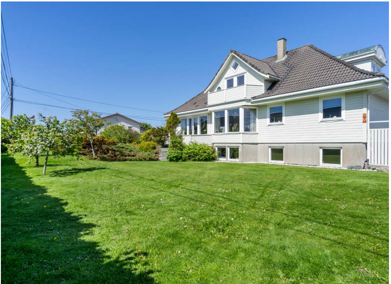
Robotklipper medfølger i handelen. Her ser man blant annet epletre/plommetre. Det er drenert langs grunnmuren på denne
